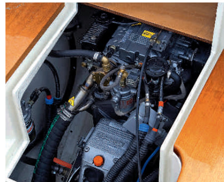
Speziell. Der Motor ist invers installiert. Der Saildrive sitzt vor dem Aggregat
